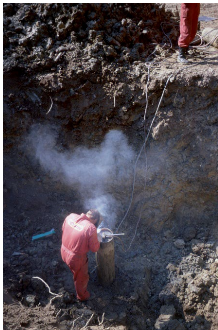
Sanacija prve naftne bušotine u Hrvatskoj na Mramor brdu kod Kutine počinje zavarivanjem cijevi, slijedi prekrivanje tlom, a zatim tretiranje sirovog tla na način da ga se privede što bliže prirodnom-netaknutom tlu na istom lokalitetu
